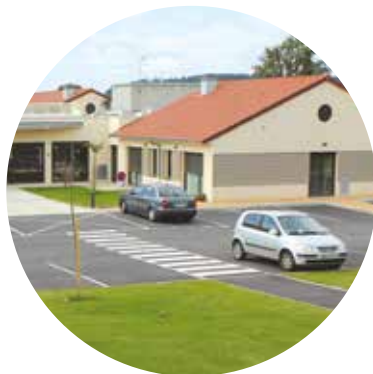
Crédit photo : Résidence du Val de Joux
